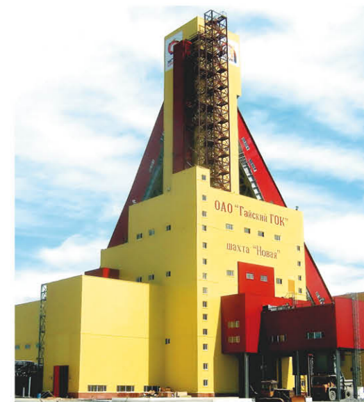
ПАО «Гайский ГОК». Строительство зданий и сооружений поверхностного комплекса шахт Новая, Клетевая, Скиповая.
