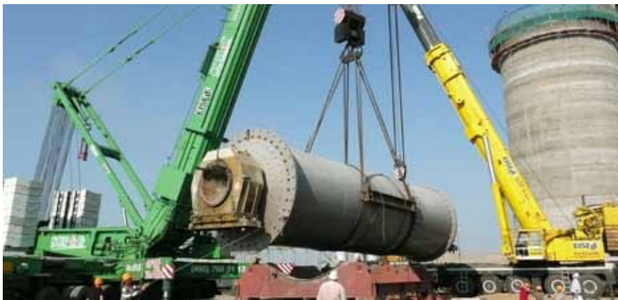
Специалисты УММ 2 приступили к монтажу Пятой технологической линии ОАО «Сухоложскцемент» в октябре 2007 года, начав с дробильного отделения. Работая в круглосуточном режиме, за два месяца они установили более 500 тонн тяжеловесного оборудования, были смонтированы цементные мельницы весом 200 и 240 тонн, вращающаяся печь общим весом 420 тонн, дымовая труба внутри железобетонного пилона и другие объекты комплекса. В течение всего проекта строительства специалисты УММ 2 смонтировали около 5 300 тонн технологического оборудования.
