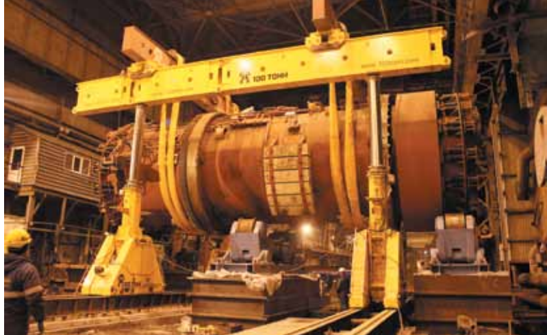
Монтаж печи на Карабашмеди
