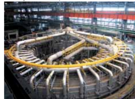
Смонтированная кольцевая печь СТЗ
