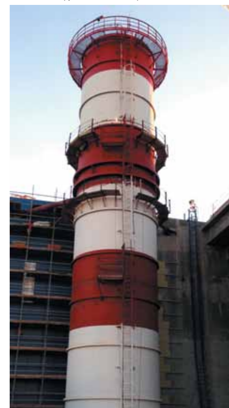
Монтаж трубы САРХ на белоярской атомной станции
