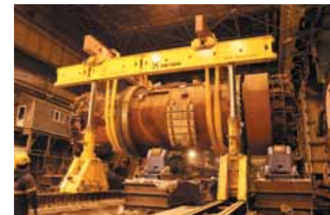
Монтаж печи на «Карабашмеди»
