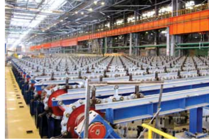
Северский трубный завод, строительство стана FQM
