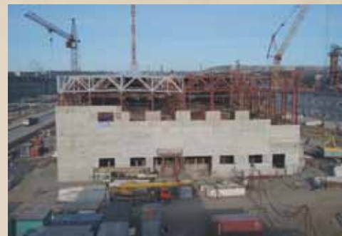
В качестве генпродрайчиков монтажники УММ 2 успешно осуществили реализацию проекта комплексной реконструкции химико-металлургического комплекса ОАО «Среднеуральский медеплавильный завод», входящий в структуру УГМК-Холдинга.
