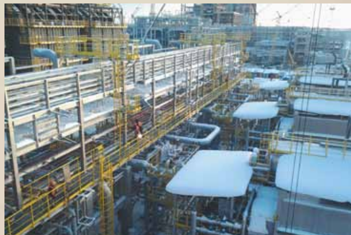
2012 г. Строящийся комплекс по производству полипропилена «Тобольск-Полимер» мощностью 500 тыс. тонн в год. Реализация этого проекта позволит России значительно увеличить объемы переработки попутного нефтяного газа, что позволит отказаться от импорта полипропилена. В рамках строительства УММ 2 ведет монтаж Установки Дегидрирования Пропана (УДП).
