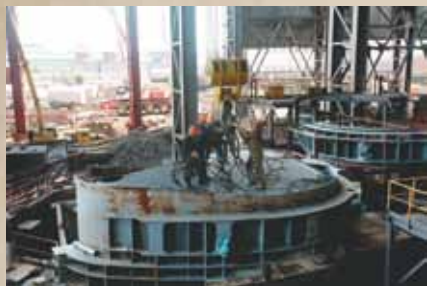
Пуск комплекса ДСП на Северском трубном заводе, входящем в Трубную Металлургическую Компанию. Строителями УММ 2 смонтированы здания ЭСПЦ, вспомогательных помещений и технологических трубопроводов, в 2008 году успешно введена в эксплуатацию современная дуговая сталеплавильная печь EAF 135 EBT немецкой фирмы SMS Demag массой 316,5 тонн.
