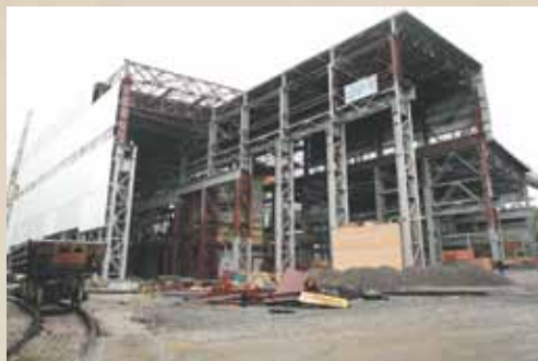
Для ТМК на Северском трубном заводе выполнен целый комплекс строительно-монтажных работ: возведен корпус здания МНЛЗ общей площадью 8000 кв.м., произведен монтаж и ввод в эксплуатацию машины непрерывного листа заготовок фирмы SMS Demag (Германия) мощностью до 1000 тонн стали в год.
