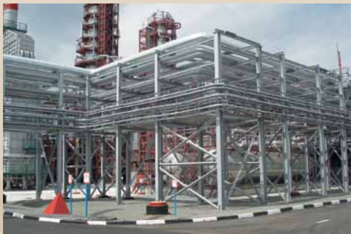
В начале 2011 года компания завершила пусконаладку в рамках возведения второго пускового комплекса ЗАО «Антипинский нефтеперерабатывающий завод» в Тюмени. За полтора года строительства осуществлен монтаж более 900 тонн технологических трубопроводов, более 550 тонн нового оборудования для переработки нефти. Этот проект отличался от традиционных для УММ 2 объемов работ сложными в техническом отношении решениями, ориентированными на особенности отраслевых стандартов строительства.
