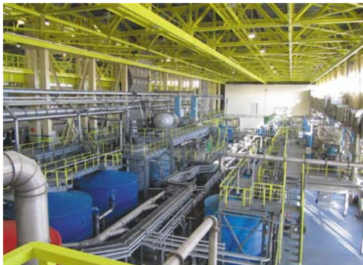
Монтаж цеха электролиза меди на предприятии «Уралэлектромедь»
