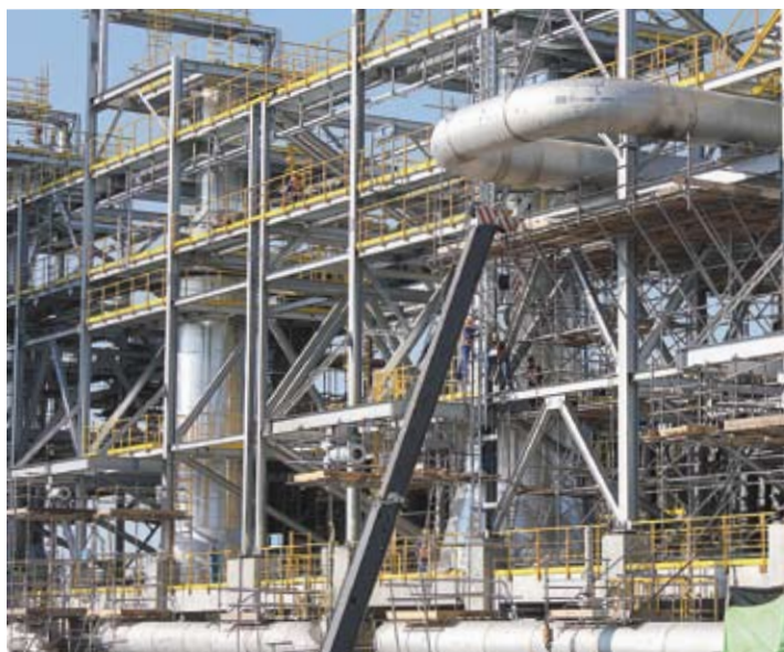
Монтаж установки дегидрирования пропана на предприятии «Тобольск-Полимер»
